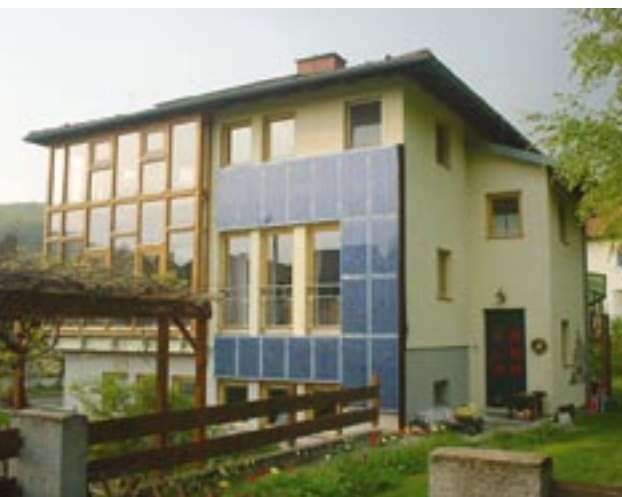
Fassadenintegrierte Photovoltaikanlage
